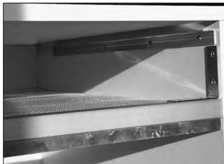
Figuur 3. Aluminium tussenbalk, schuifprofiel en gazen rooster. Picture 3. Aluminum beam, sliding strip and wire mesh.
